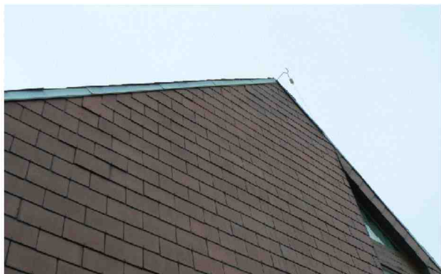
Le fil arrive au faite du toit (venant de la gauche) à un isolateur " oeuf " attaché à la pipe et descend vers le fond du jardin, jusqu'à une hauteur de 2m
