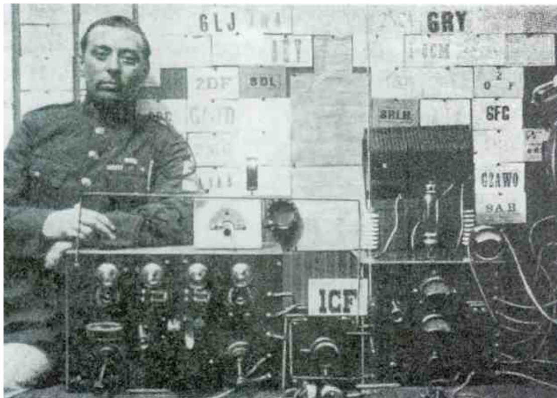
Jacques HEYNEN S/Officier Bataillon-Radio Vilvorde Belgique. Faisait du 80m avec 2 lampes TM sous 220V. Description de sa station dans le 'Jd8' N°10 du 5 Juillet 1924.
