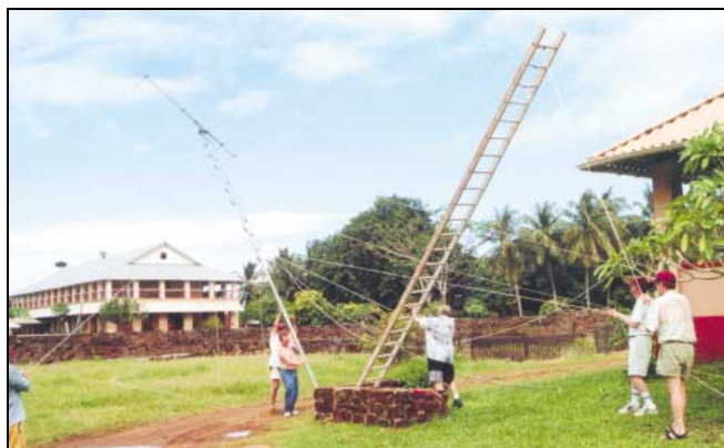
Comment démonter des aériens 50 MHz.
