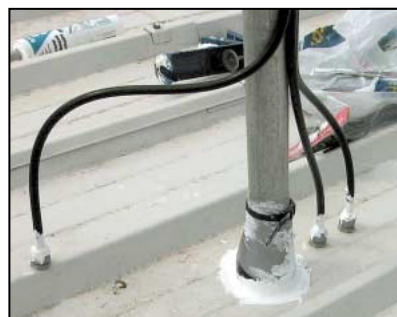
Traversées du mât porteur et des câbles.
