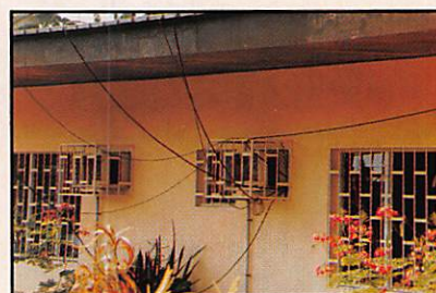
Arrivée des coax par le climatiseur.
