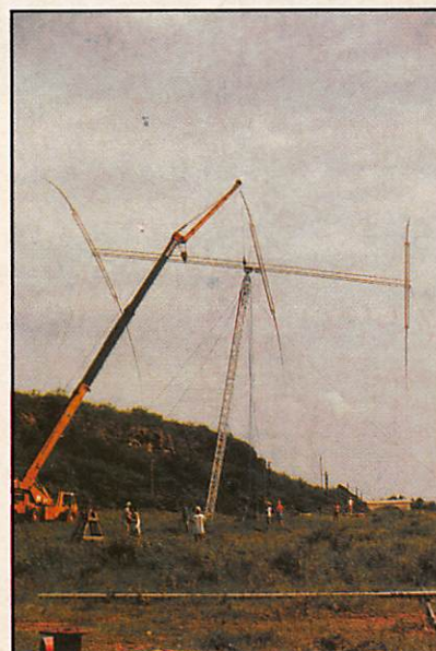
Montage de l'antenne 80 m avec une grue.
